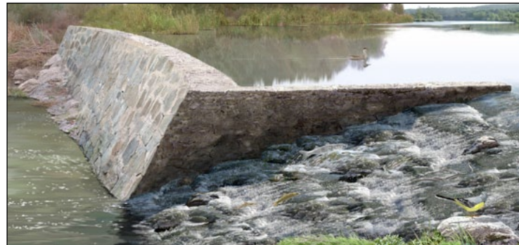
Dispositiu de pas per a peixos (rampa per a peixos) en una resclosa. Il·lustració de Toni Llobet a Ordeix i Bretxa (2007).
